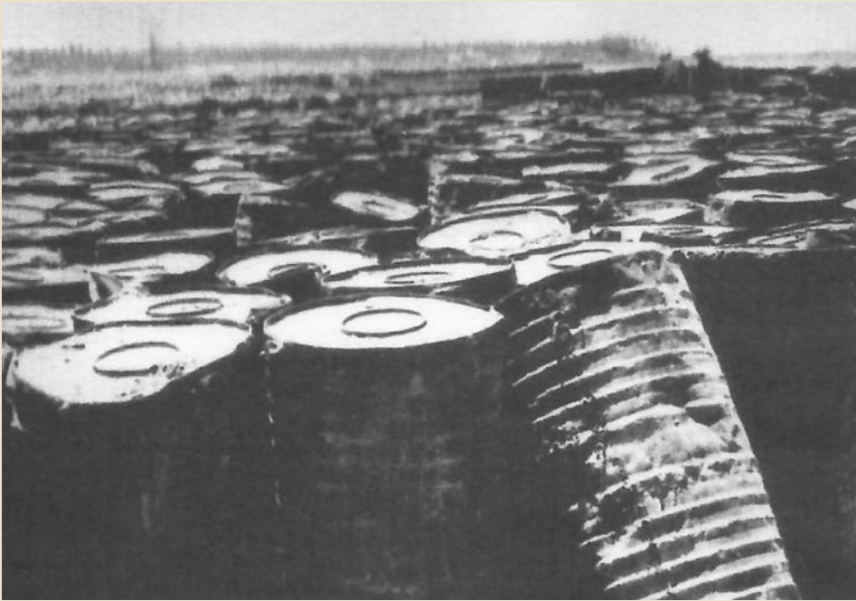
Arsip Foto Kempen Bali Ribuan drum asphalt AC-60-70 untuk campuran aspal beton runway .
