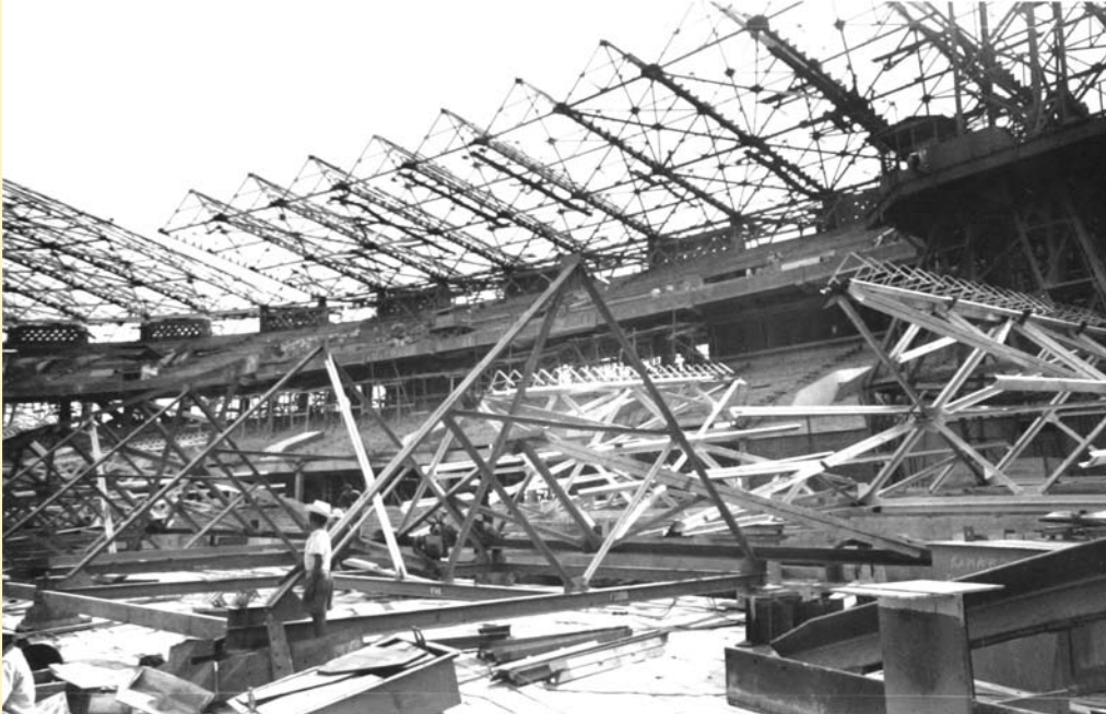
Pembangunan Stadion Senayan
