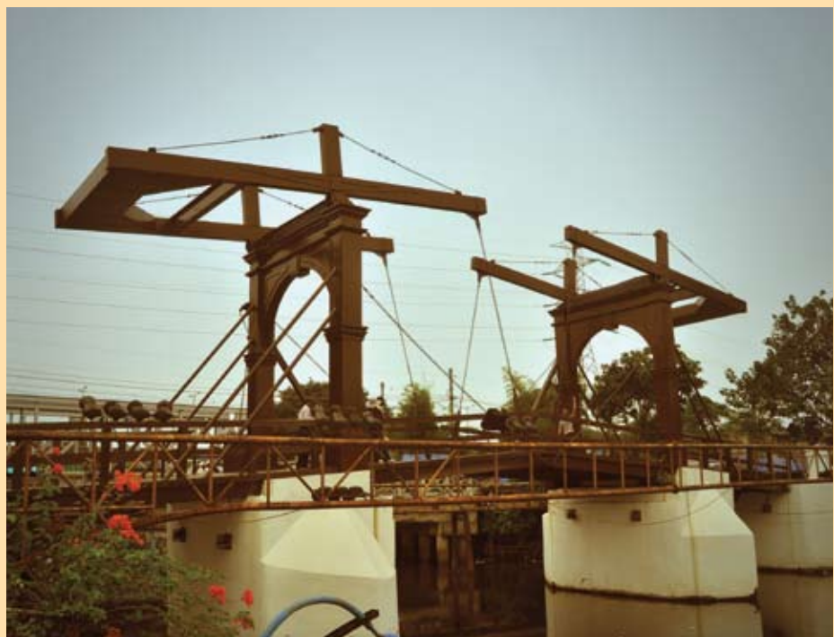
Jembatan Kota Intan
