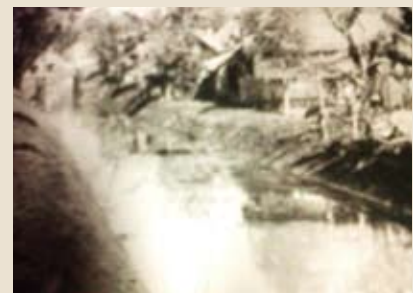
Saluran air yang telah dikerjakan di Batavia, [1920] Sumber: ANRI, KIT Batavia No.142/05
