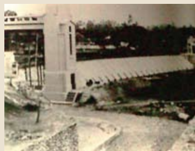
Pintu Air Manggarai yang telah selesai dibangun, Batavia, [1920] Sumber: ANRI, KIT Batavia No.530/34
