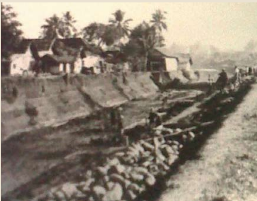
Pembangunan banjir kanal di Oude Tamarindelaan (sekarang Jl. KH Wahid Hasyim) dekat Kebon Sirih, [1920] Sumber: ANRI, KIT Batavia No. 531/87
