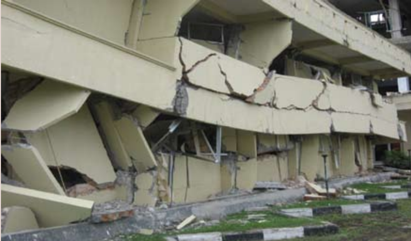
Hancurnya Bangunan Depo Badan Perpustakaan dan Kearsipan Provinsi Sumatera Barat Akibat Gempa 30 September 2009
