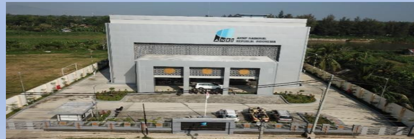
Balai Arsip Statis dan Tsunami Aceh Bakoy, Aceh Besar
