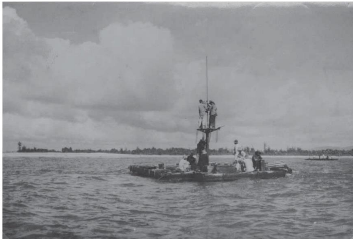
Pengeboran lepas pantai untuk tambang timah di sekitar Pulau Bangka dan Belitung, [1949].
