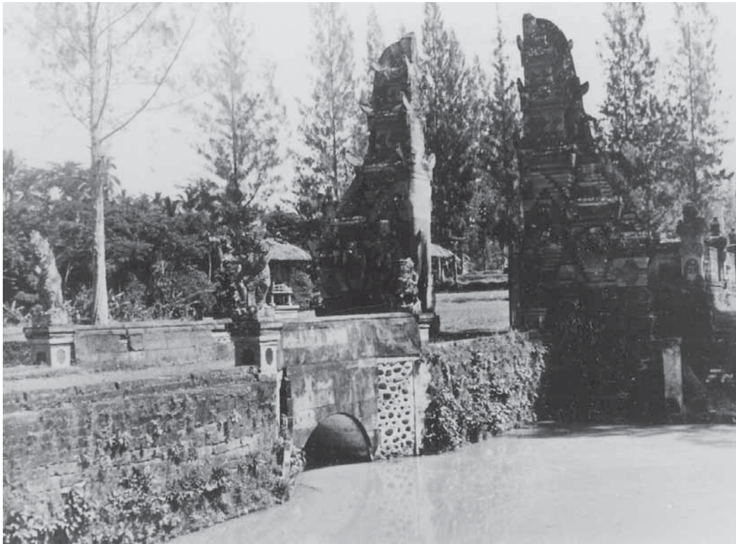
Jembatan dengan terowongan air di pintu gerbang sebuah pura di Mengwi, Bali.
