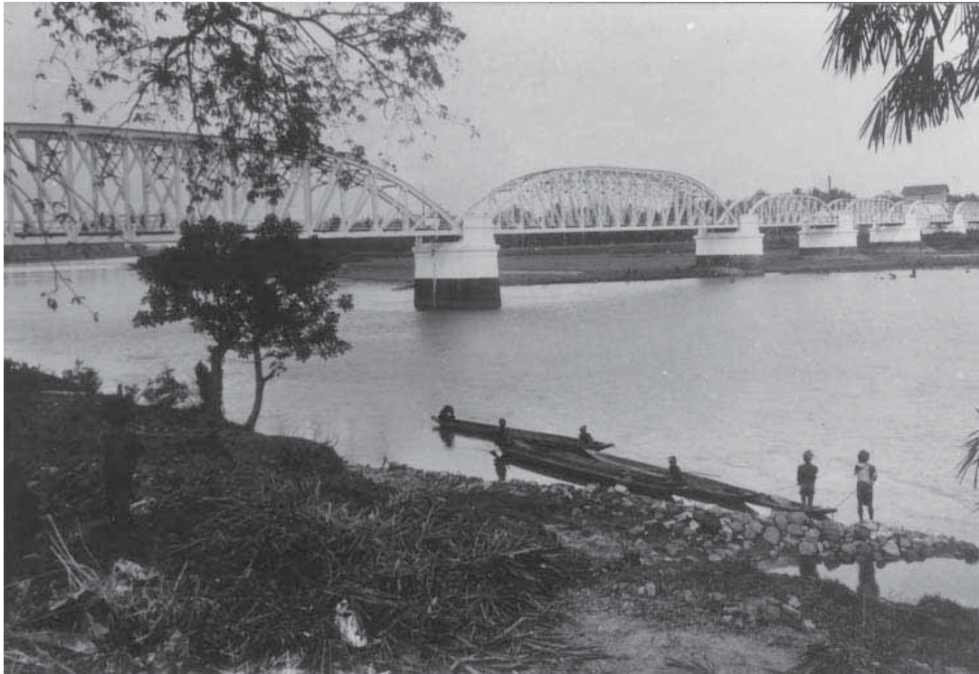
Jembatan kereta api jurusan Cirebon-Kroya, Jawa Barat, [1930]
