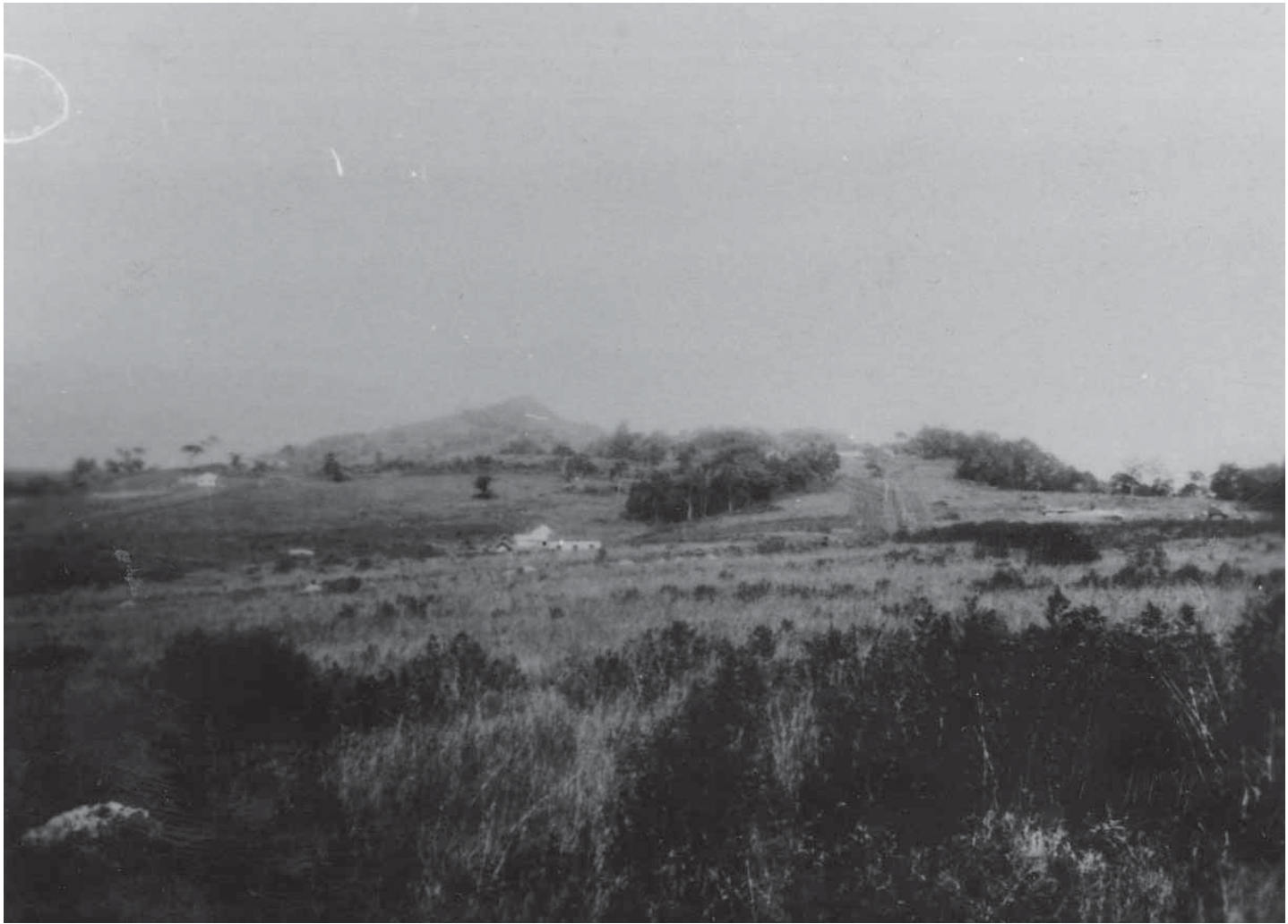
Pemandangan dari Timur-Barat dataran Malino yang ditengahnya terdapat Pusat Listrik Tenaga Air, Malino, Sulawesi Selatan, 1931.
