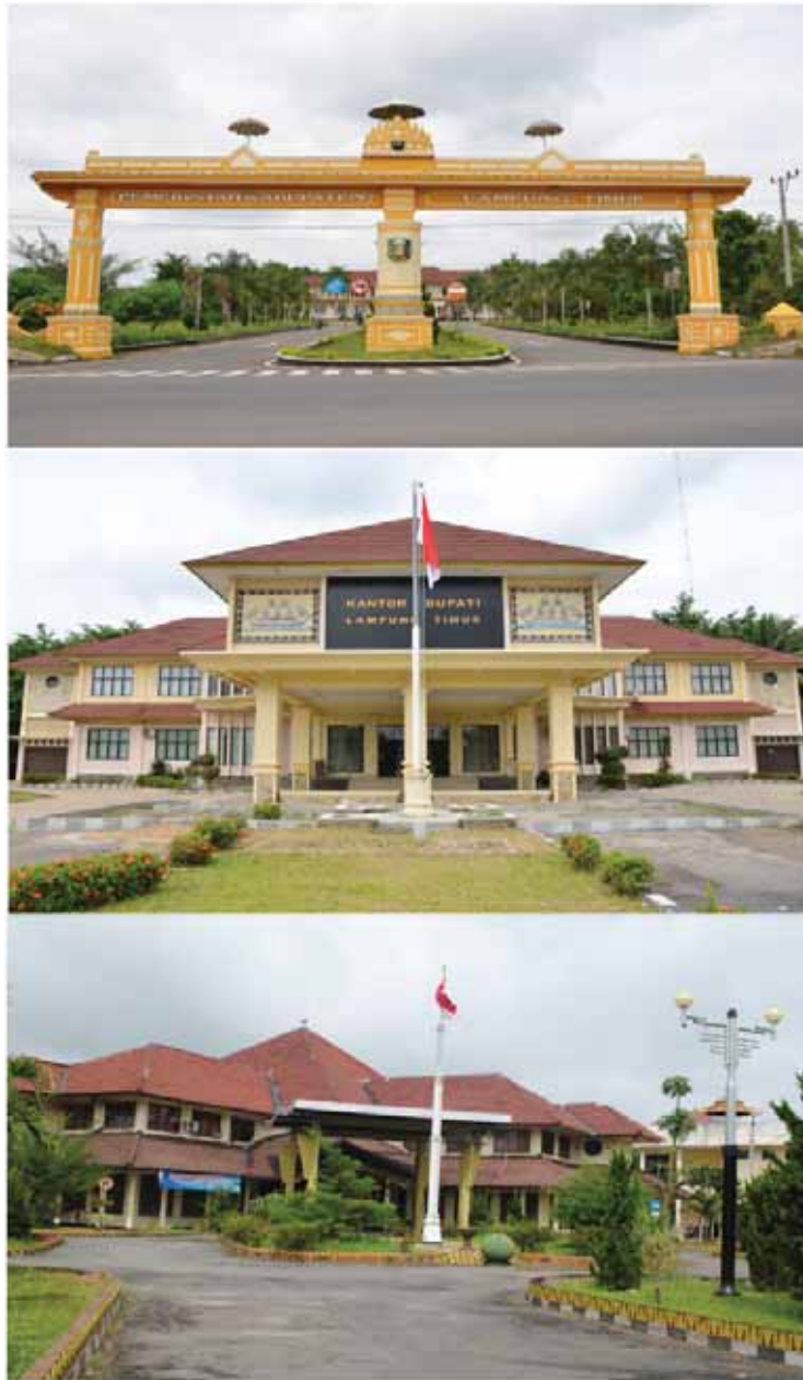
Gedung Perkantoran Pemda Kabupaten Lampung Timur di Sukadana
