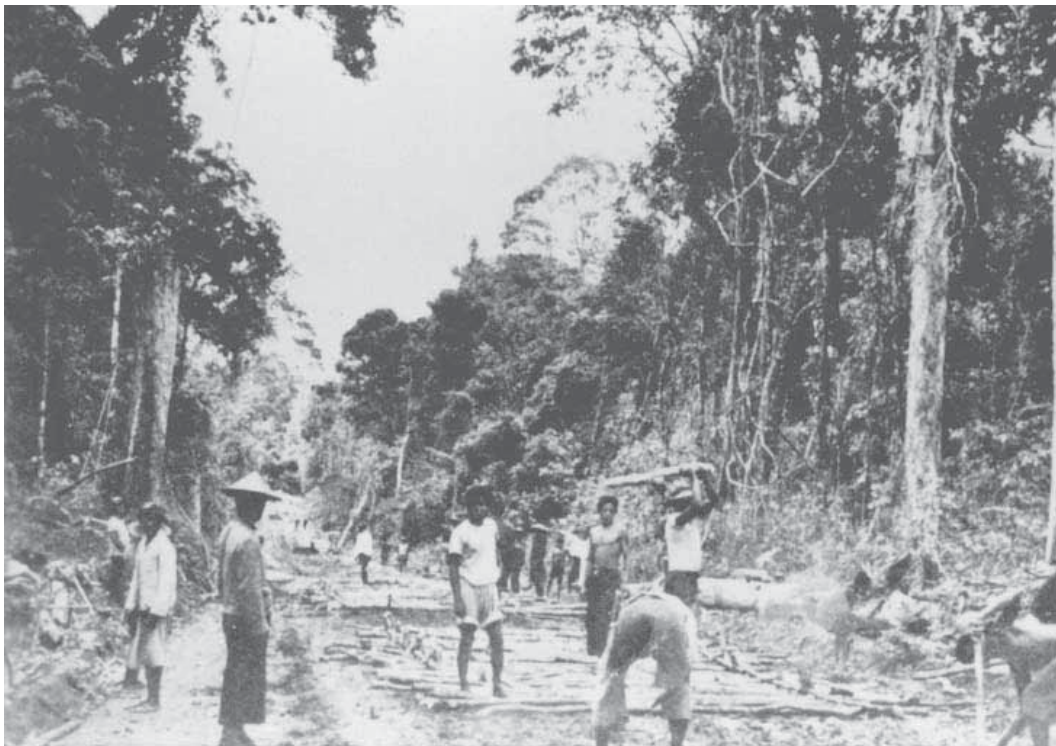
Pembukaan lahan untuk jalan kolonisasi, Lampung. [1930]
