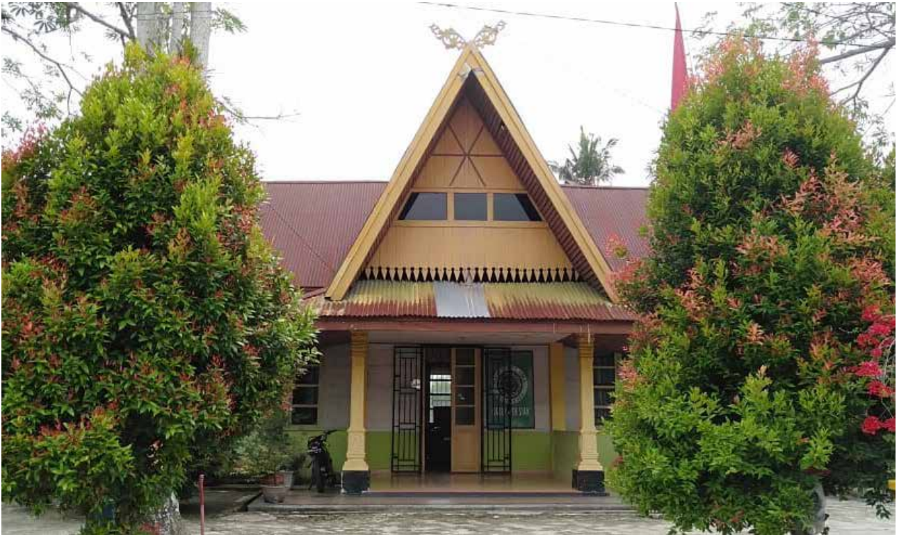
Gedung bekas Madrasah Taufiqiyah Al Hasimiyah (saat ini digunakan untuk gedung Baznas Siak), 2019 Sumber: Dinas Perpustakaan Kabupaten Siak
