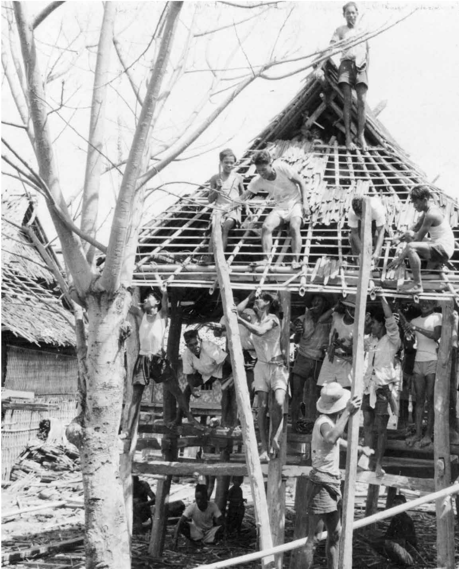
Pembangunan rumah dengan cara gotong royong di Sumbawa, 5 November 1954. Sumber : ANRI, Kempen NTT Tahun 1950-1965 No. 174
