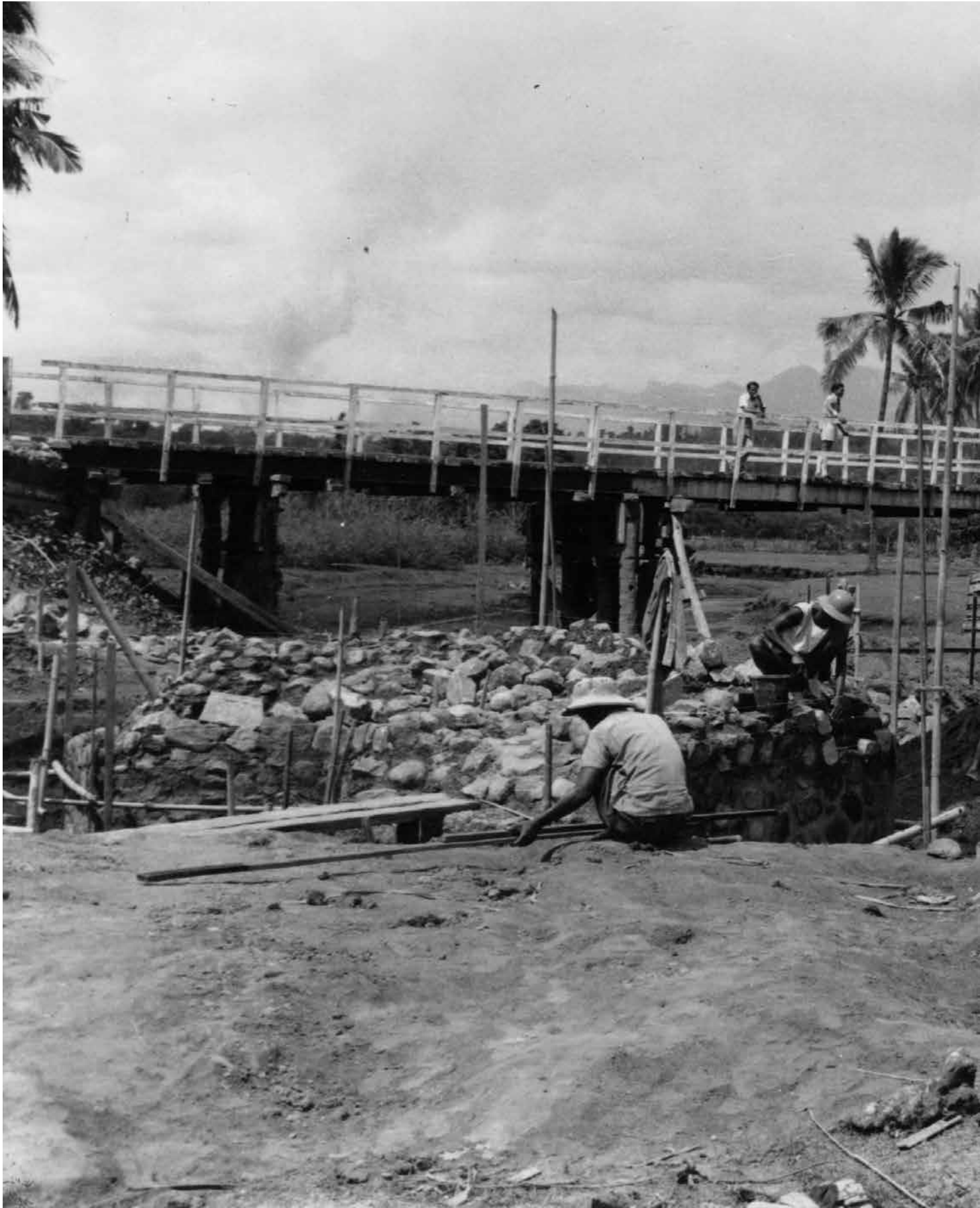
Pembangunan jembatan di Sumbawa, November 1954.
