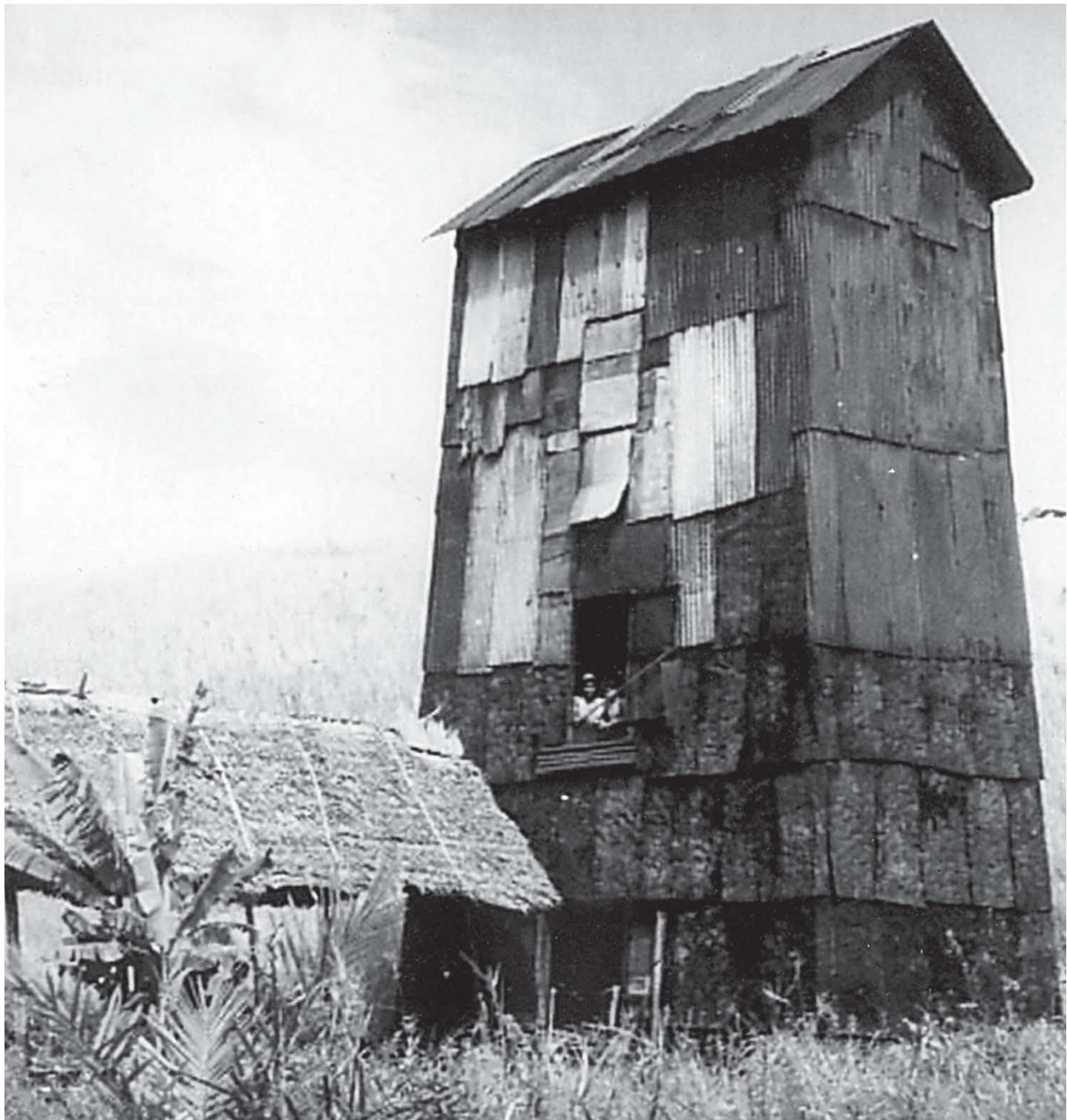
Menara pengintai milik Pertamina, Balikpapan, tanpa tahun. Sumber: Kantor Arsip dan Perpustakaan Kota Balikpapan
