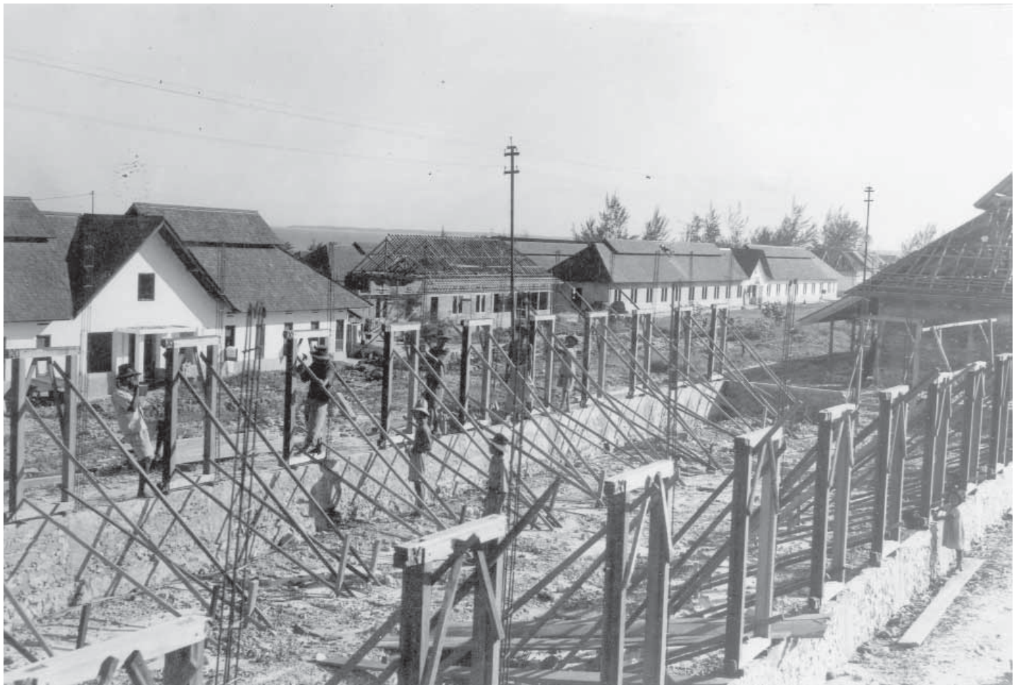
Pembangunan perumahan di Balikpapan, 19 Juli 1947.
