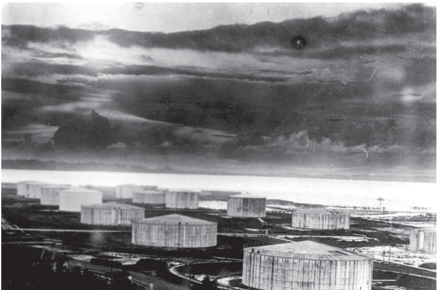
Tangki instalasi minyak di Balikpapan, [1940].
