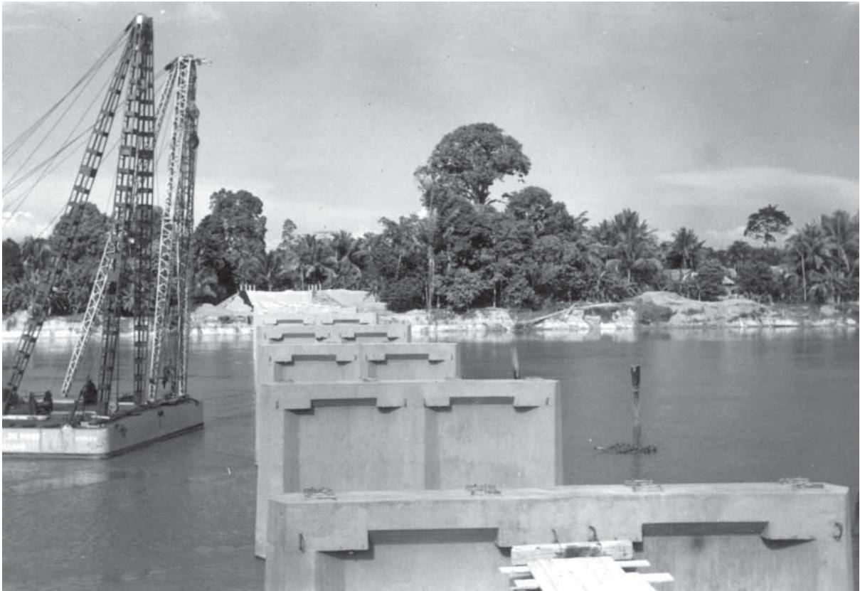
Pembangunan salah satu jembatan di atas Sungai Musi, Palembang, pembangunan pilar-pilar beton untuk jembatan dengan menggunakan perahu derek, 14 Desember 1953
