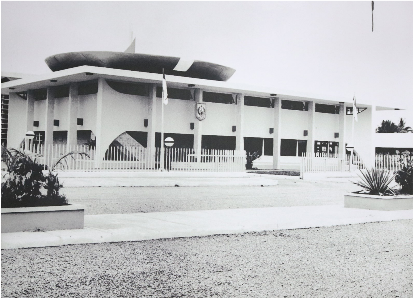
Gedung DPRD Provinsi Riau Tahun 1971 terletak di Jalan Jendral Sudirman sekarang menjadi Gedung Perpustakaan Soeman HS Sumber: PT Chevron Pacifik Indonesia
