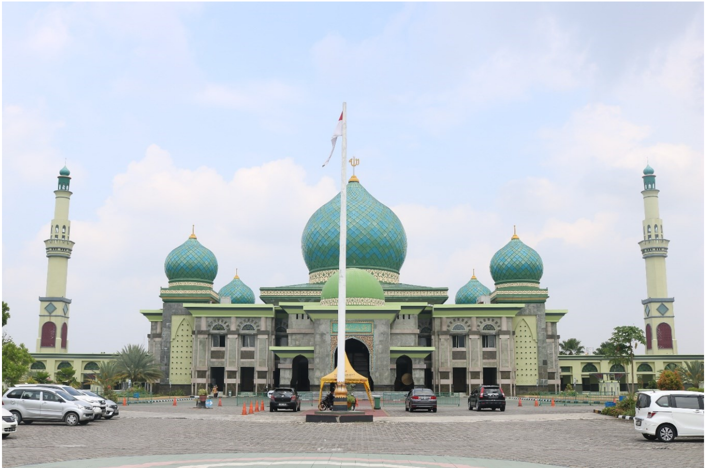
Masjid Raya Annur Pekanbaru, selesai dibangun pada tahun 1968 dan diresmikan oleh Gubernur Riau, Arifin Ahmad. Pada tahun 2000, mesjid ini direnovasi total. Sumber: Dinas Perpustakaan dan Kearsipan Kota Pekanbaru
