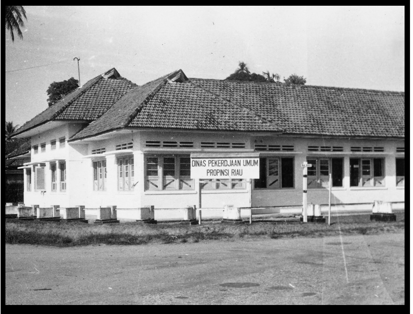
Dinas Pekerjaan Umum Provinsi Riau pada tahun 1968. Kantor ini kemudian dirobohkan pada saat Dinas Pekerjaan Umum pindah ke jalan S.M Amin. Sumber: Dinas Perpustakaan dan Kearsipan Kota Pekanbaru
