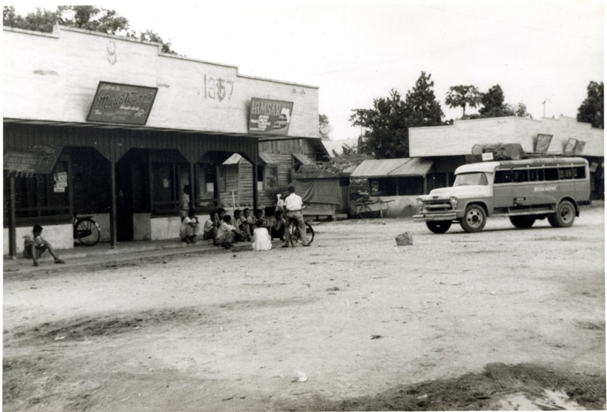
Stasiun Bus Pekanbaru sudah pulih kembali setelah sehari sebelumnya dilanda banjir. 16 Mei 1958 Sumber: ANRI, KEMPEN SUMATERA BARAT 1955-1965 NO. 3042
