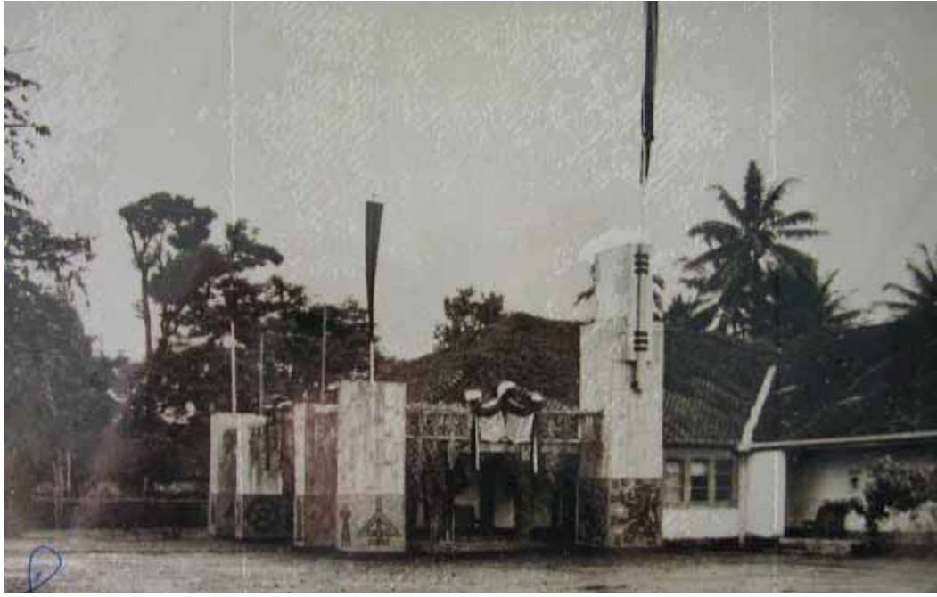
Kantor dinas Pekerjaan Umum di Jalan Bhayangkara, Sukabumi, 1930
