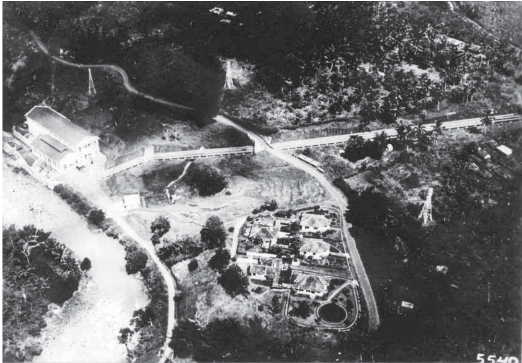
Gambar udara Pembangkit Listrik Tenaga Air Ubrug, Sukabumi, (dilihat dari arah danau penampungan air Ci Catih), [1930]
