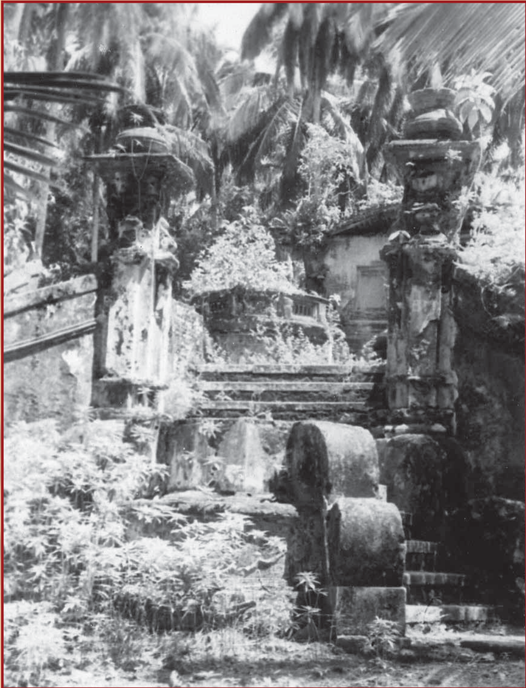
Bangunan bekas Istana Sultan Riau di Pulau Penyengat, Kepulauan Riau, 5 Agustus 1951.
