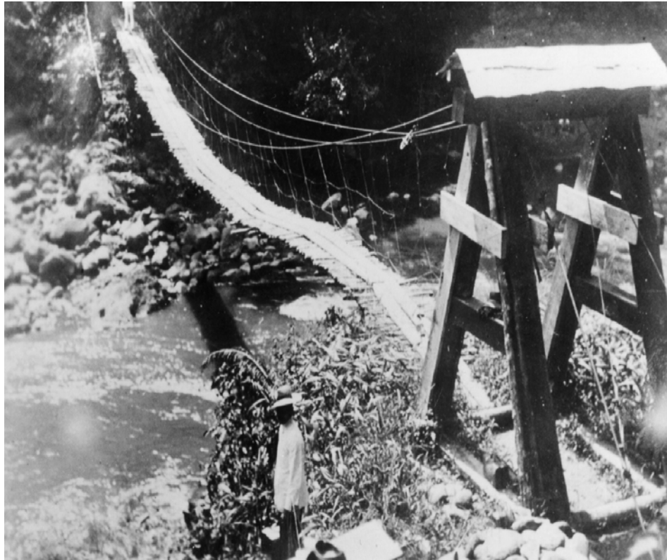
Jembatan yang terbuat dari bambu sebagai alat penghubung di Lebong Sulit, Bengkulu [+ 1930] ANRI: KIT 526/42
