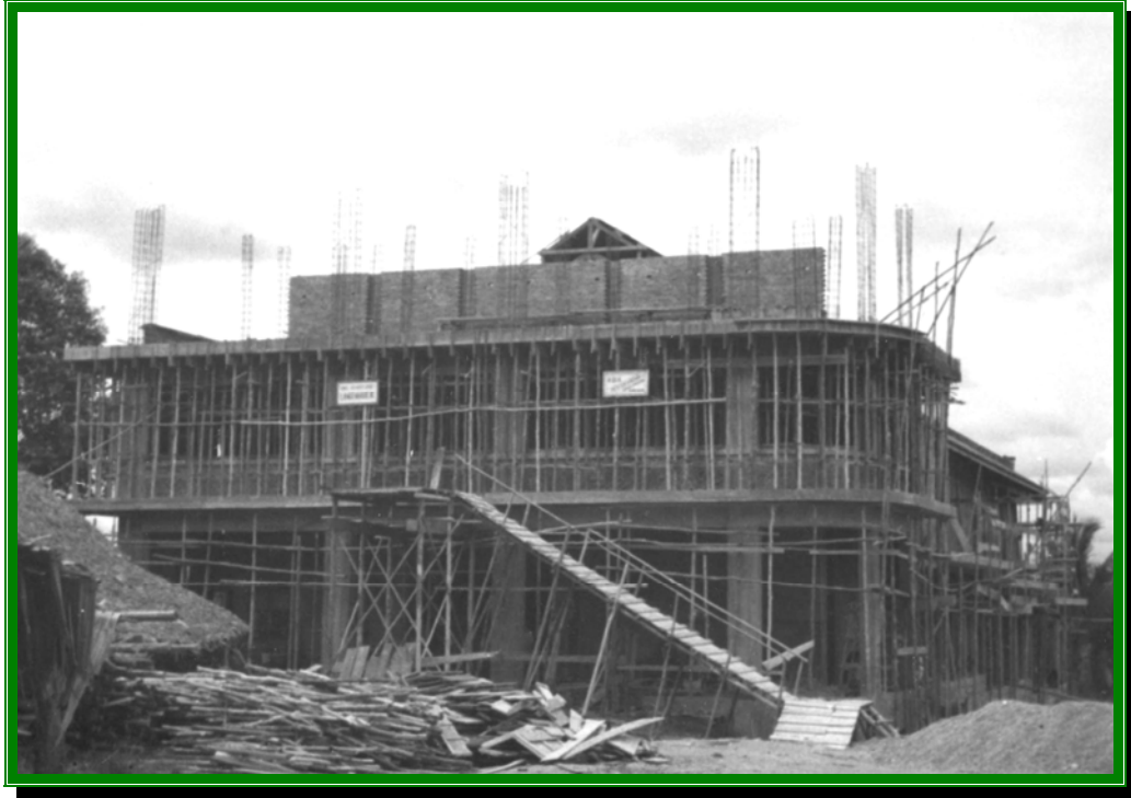
Pembangunan gedung bioskop di Jambi, 8 Desember 1953.
