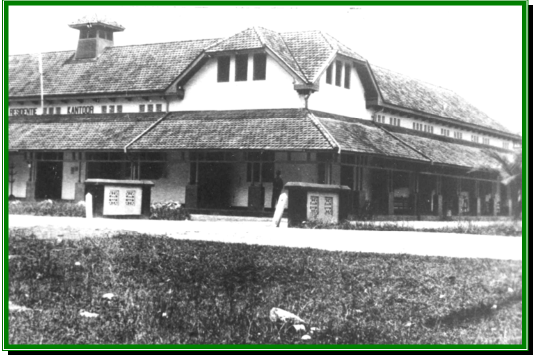
Kantor Residen Jambi, tampak dari sisi sudut bangunan terdiri atas dua lantai, 1928.
