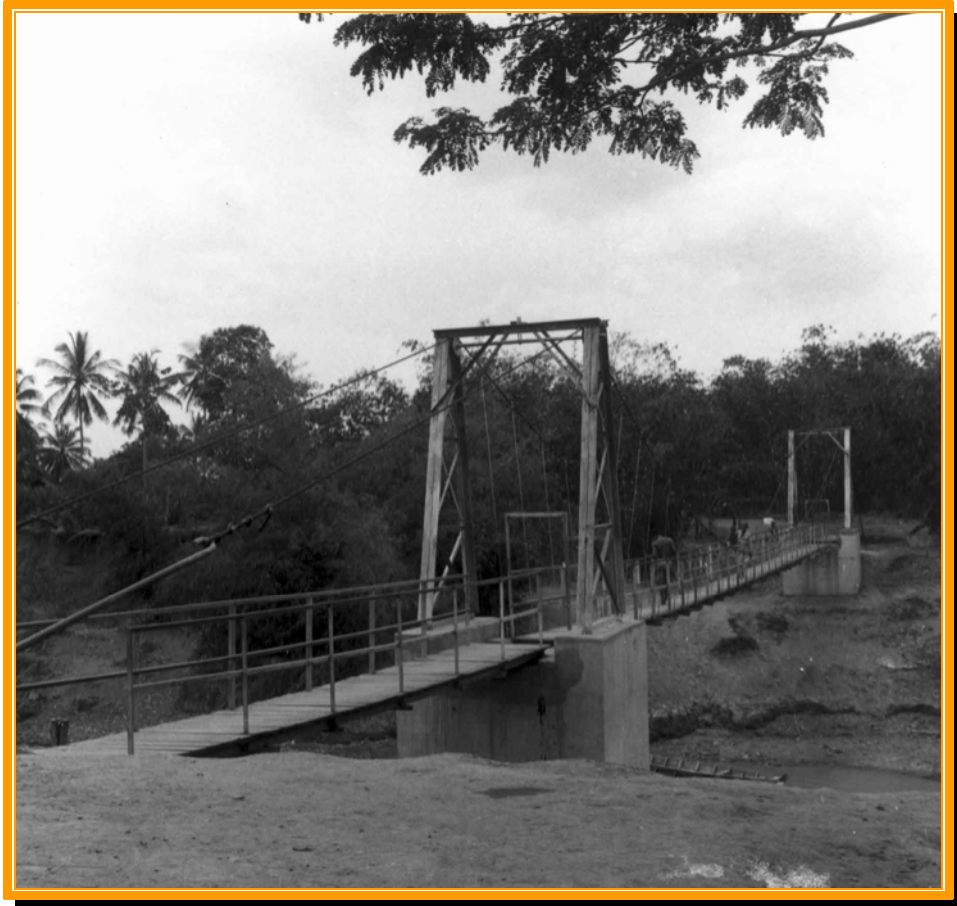
Jembatan gantung sepanjang 40 meter, Bekasi, 14 Oktober 1957.
