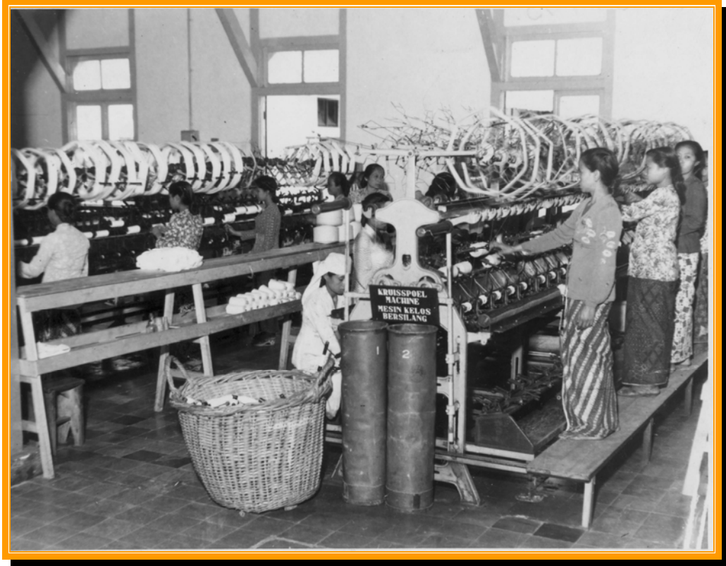
Bagian pemintalan dengan mesin kelos bersilang di pabrik tenun Bandung, 23 Mei 1952.
