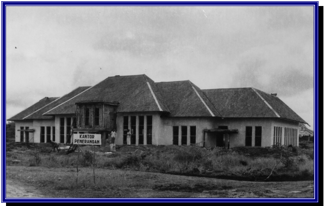
Pembangunan kantor Jawatan Penerangan Propinsi Kalimantan di Banjar Baru, Januari 1957 ANRI : Kempen
