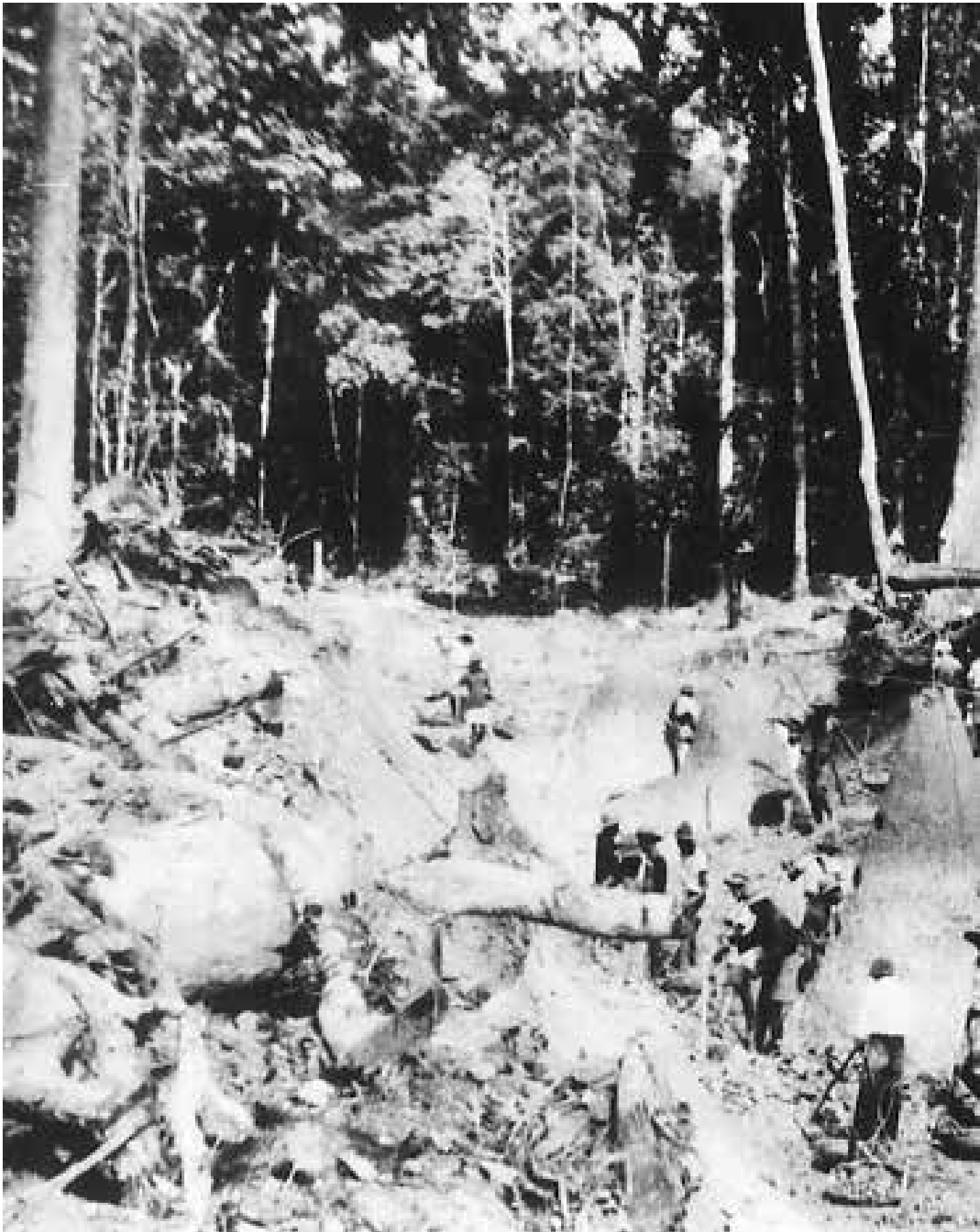
Pembuatan jalan di tengah hutan di Nunukan, 1930.
