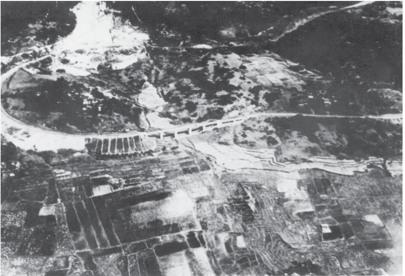
Jalan kereta api Padalarang - Karawang, Jawa Barat, [1930].
