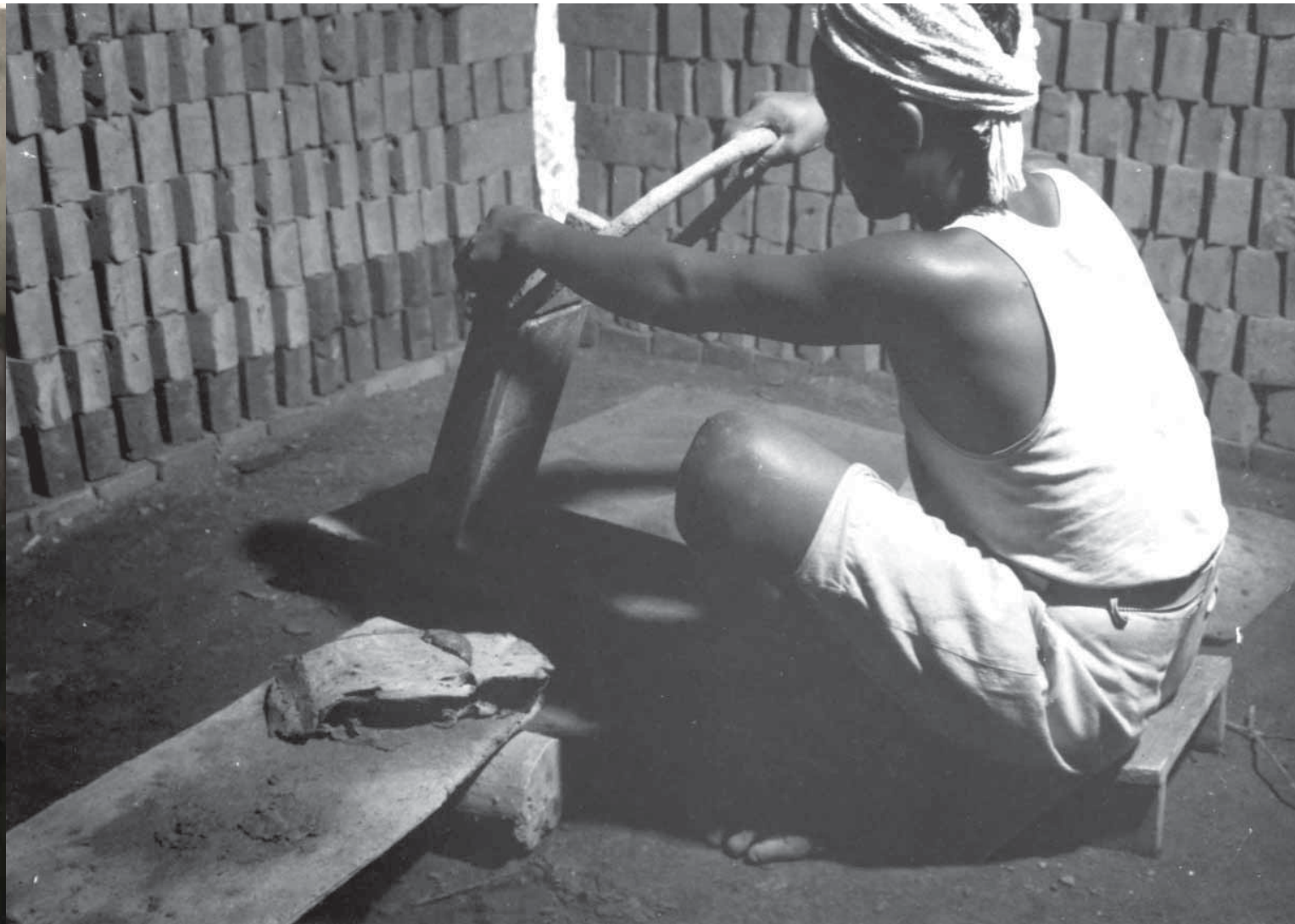
Seorang pekerja sedang mencetak batu bata yang terbuat dari tanah liat di Perusahaan Genteng dan Batu Bata Melati di Jambi, 4 Desember 1953.
