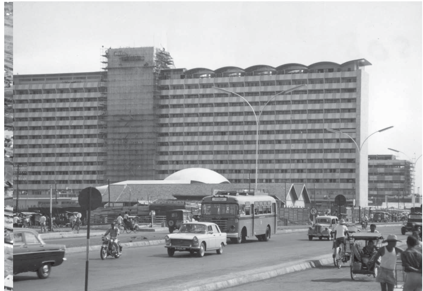
Pemandangan Hotel Indonesia dalam tahap pembangunan, 1962. ANRI, Depen 62-3508
