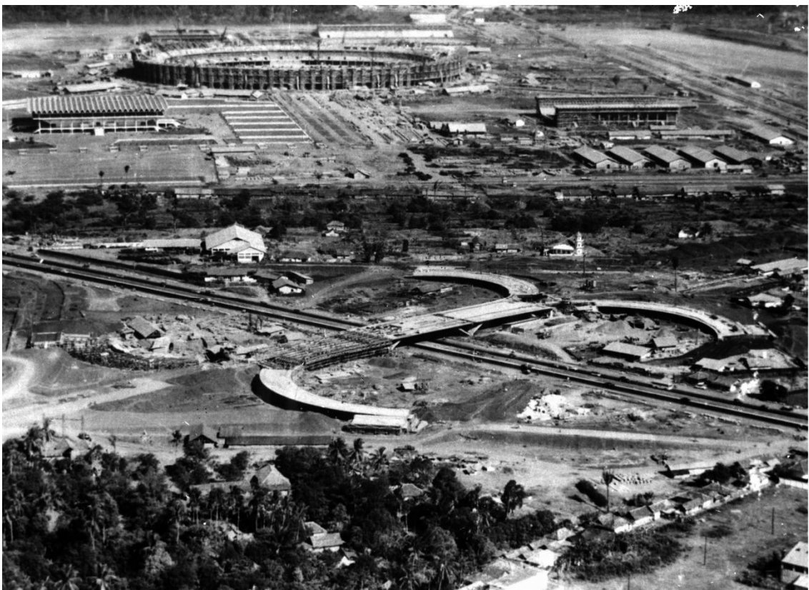
Pembangunan Stadion Utama Gelora Bung Karno, Istora Senayan dan Jembatan Semanggi, 15 Maret 1962. (Sumber: Koleksi ANRI, Kementerian Penerangan RI Wilayah DKI Jakarta 1962 No. 20315 FG 5)
