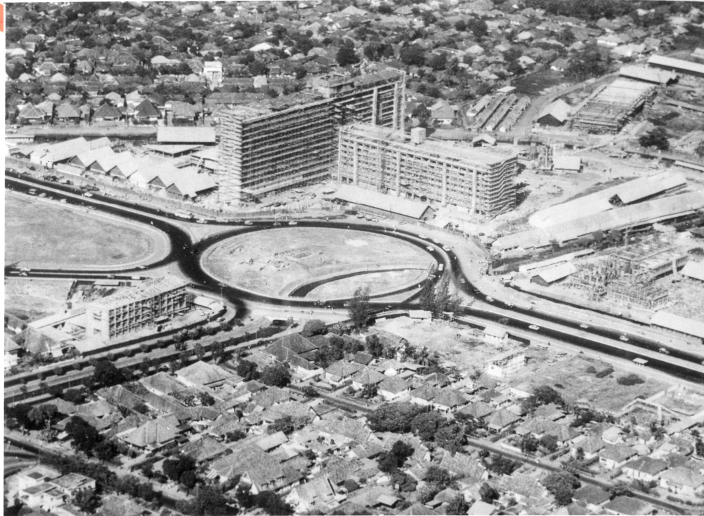
Pembangunan Kompleks Hotel Indonesia, 1962.
