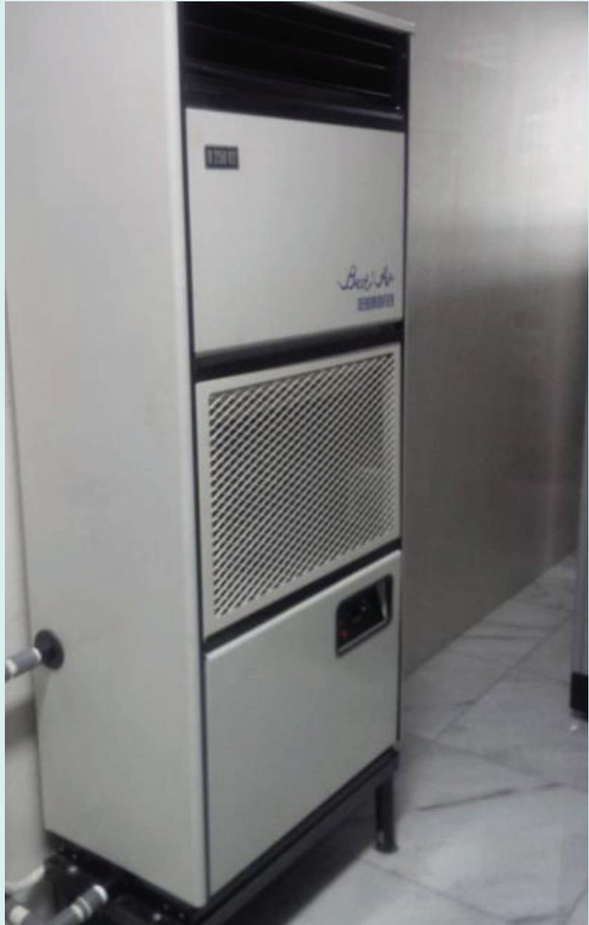
Dehumidifier (pengatur kelembaban udara) di Treaty Room , 4 Mei 2017
