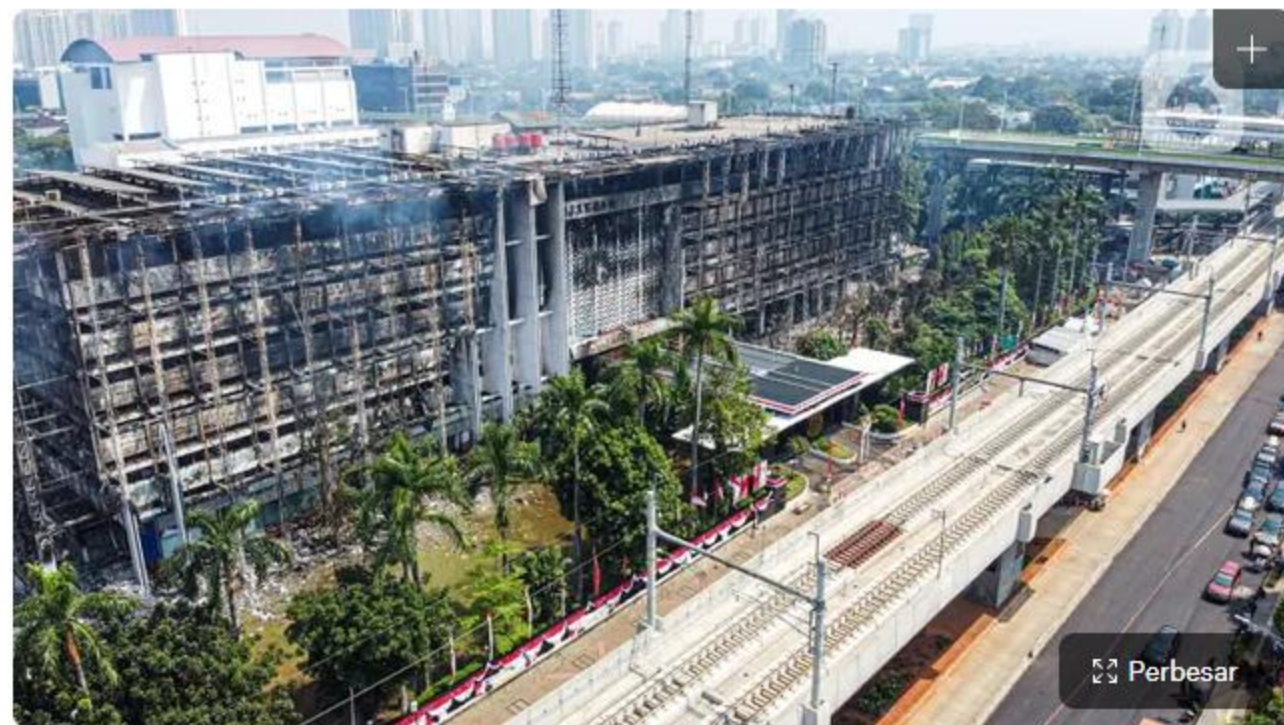
Foto udara gedung utama Gedung Kejaksaan Agung Republik Indonesia usai kebakaran hebat di Jakarta, Minggu (23/8/2020). Kebakaran selama 11 jam menyebabkan gedung utama Kejaksaan Agung, baik sayap kanan maupun kiri, hangus terbakar. (Liputan6.com/Faizal Fanani)
